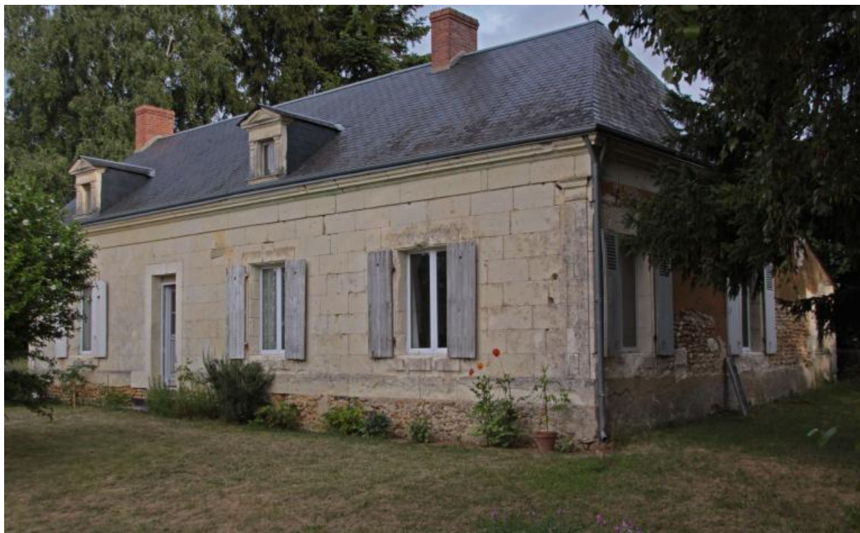
Vue de volume depuis le sud-est.
