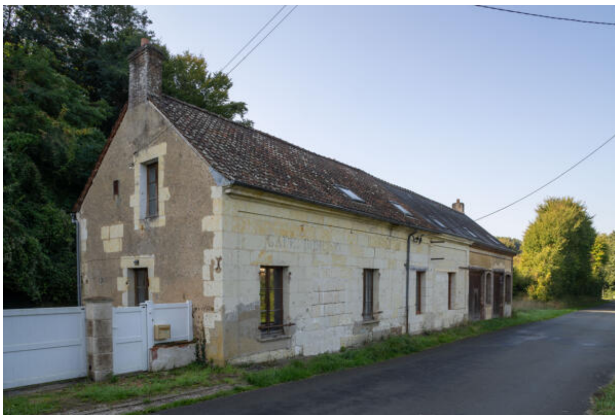
Vue d'ensemble depuis la route.
