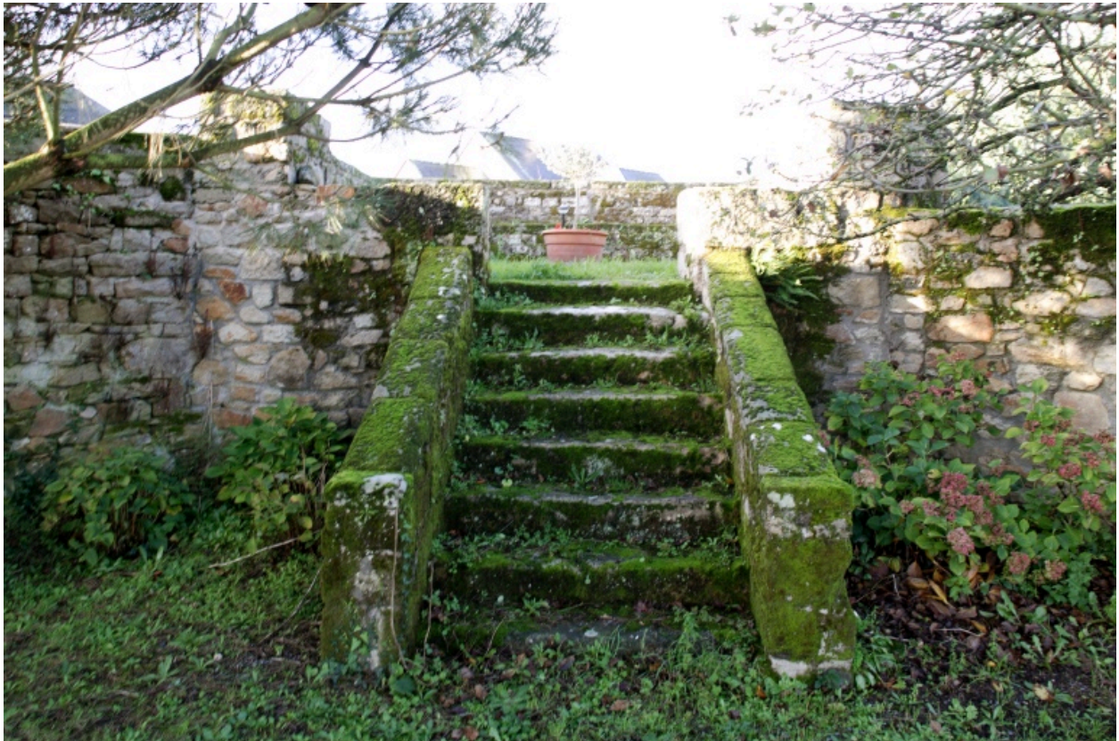
Emmarchement du belvédère vu vers le Sud.
