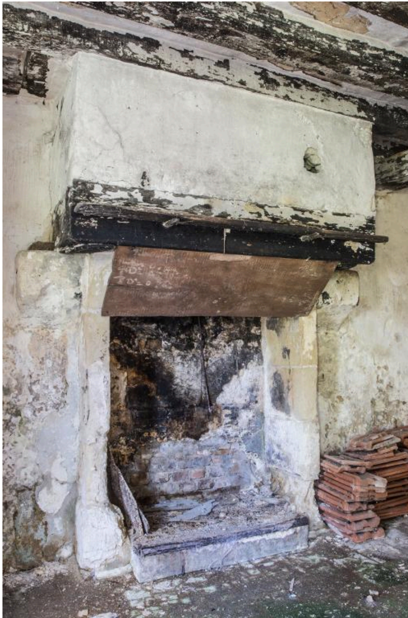
Intérieur, chambre à feu ouest : cheminée.
