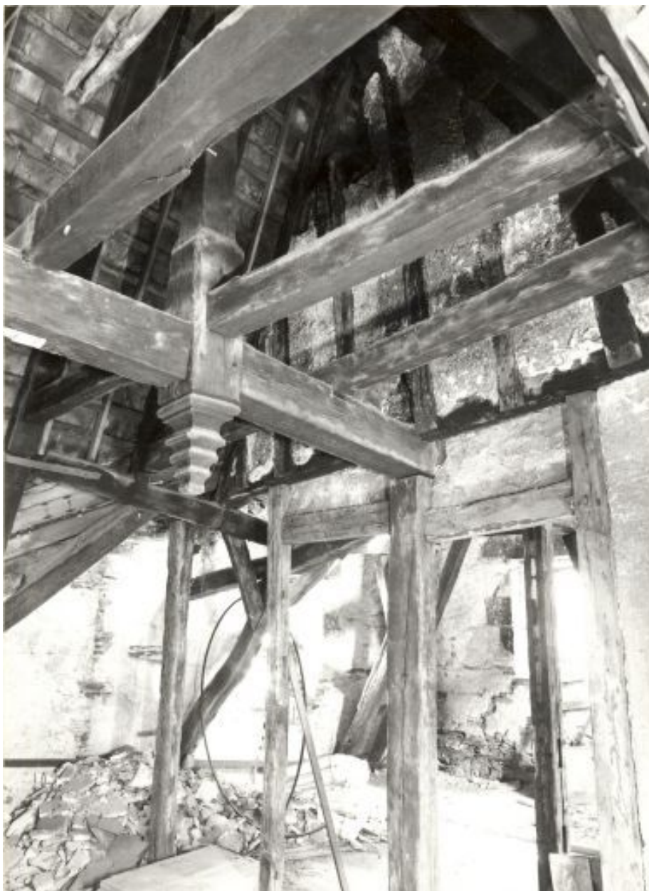
Logis postérieur, étage de comble.
