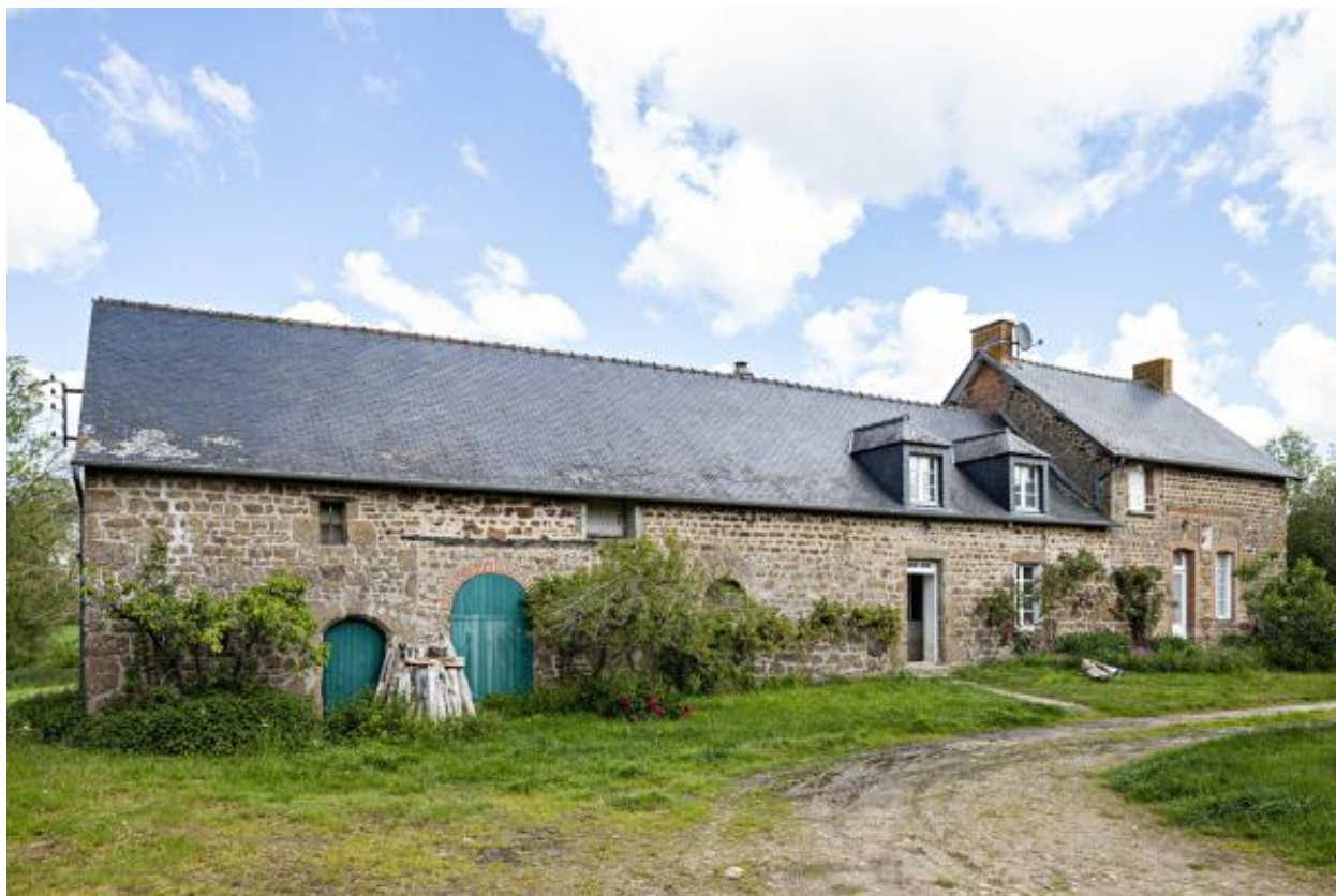
Corps de bâtiment principal : logis et cellier.
