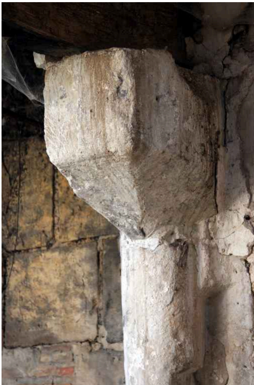
Maison n°2 : piédroit de la cheminée.
