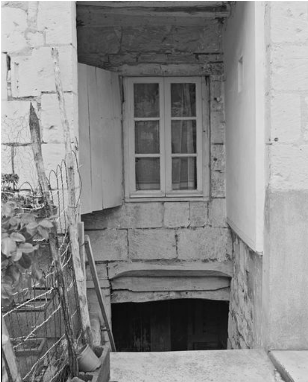
Dépendances sur cour, aile ouest : descente de cave (état 1996).
