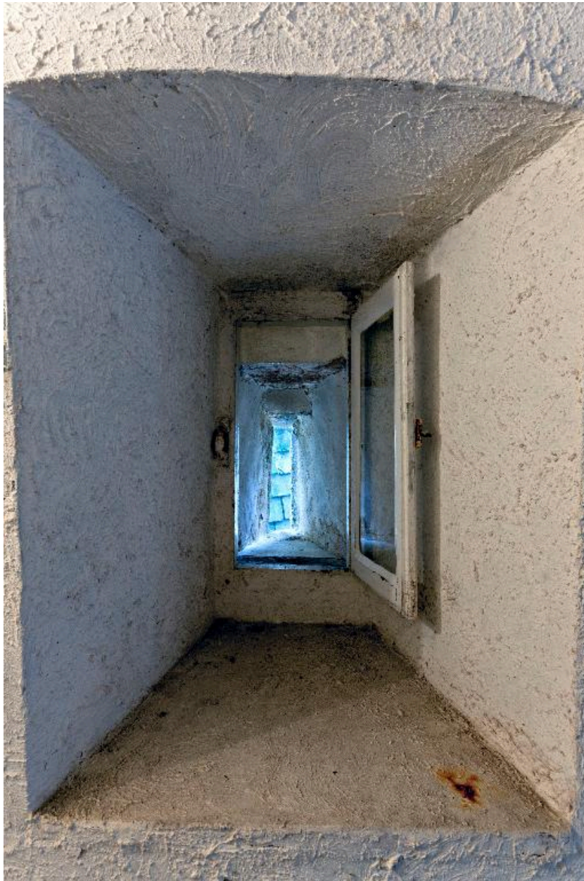
Rez-de-chaussée de la tour nord : l'ouverture ménagée dans la chambre de tir est.
