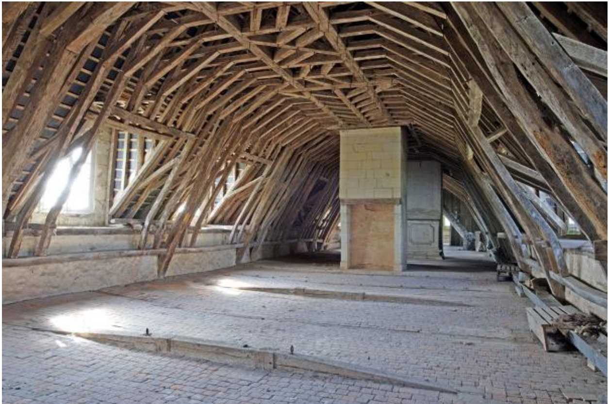
Le grand comble et sa charpente.
