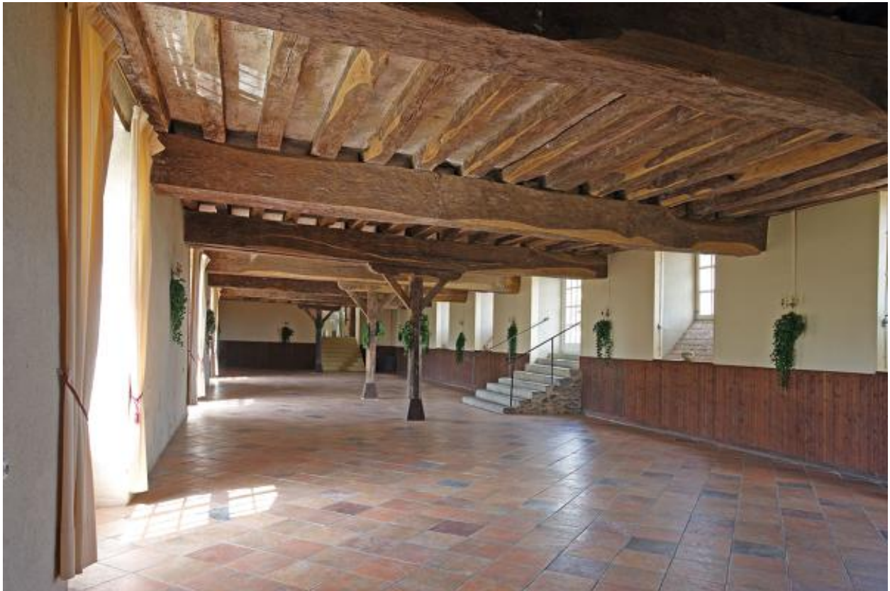
Le corps de commons dit "grange d'abondance", rez-de-chaussée.
