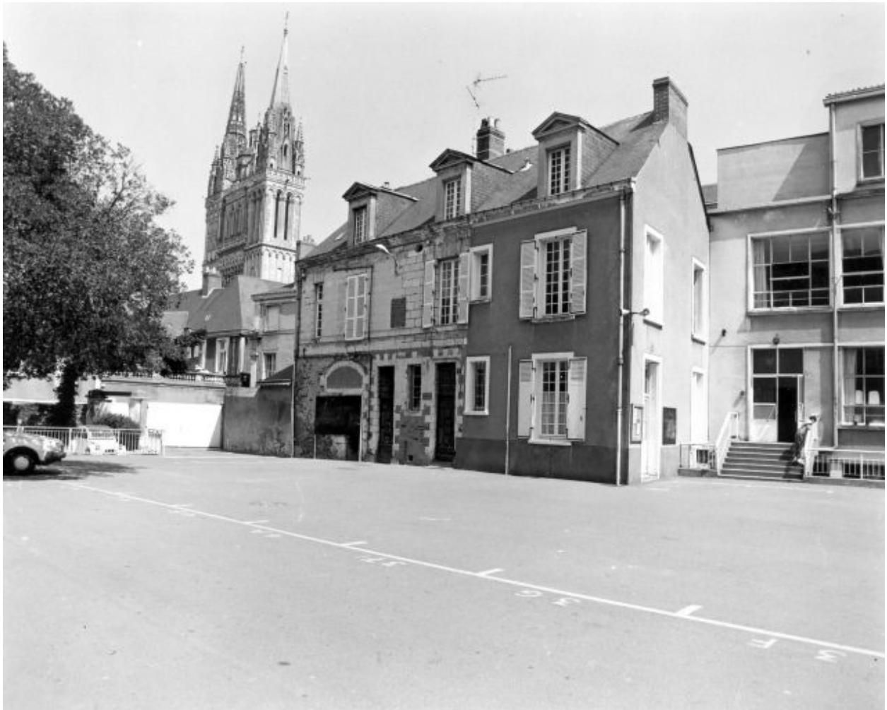
Elévation antérieure et pignon droit.
