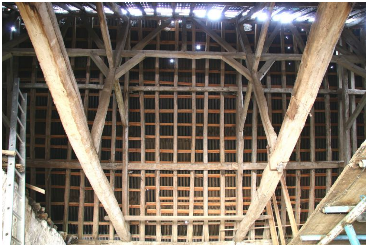
Charpente à sous-faîtage.
