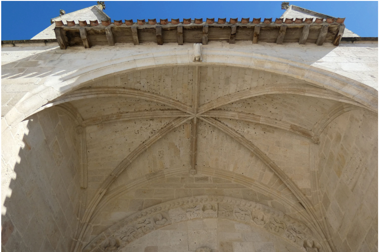
Voûte du passage entre les deux contreforts de la façade occidentale.
