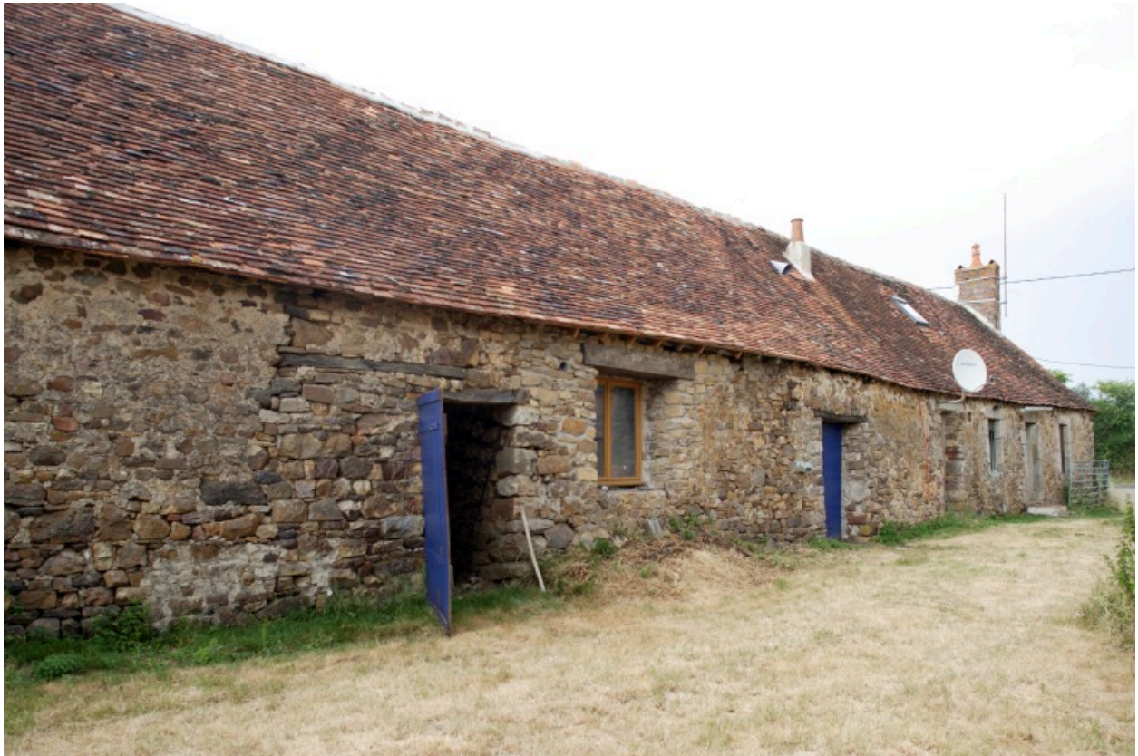
La façade principale du logis-étable vue depuis le sud-ouest.
