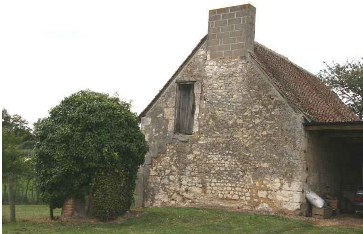
Porte du grenier dans le pignon.
