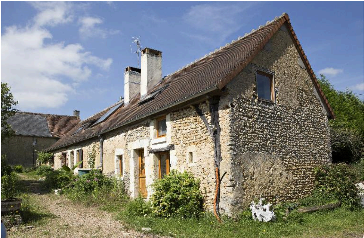
Ferme résultant d'adjonction de différentes époques, vue de volume.
