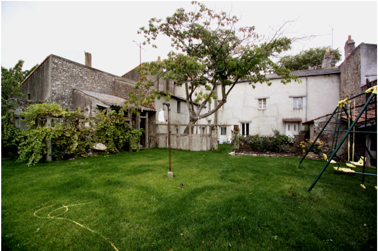
La façade postérieure vue depuis le jardin.
