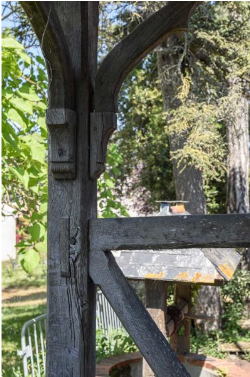
Pavillon de jardin. Détail du poteau cornier et de la balustrade.
