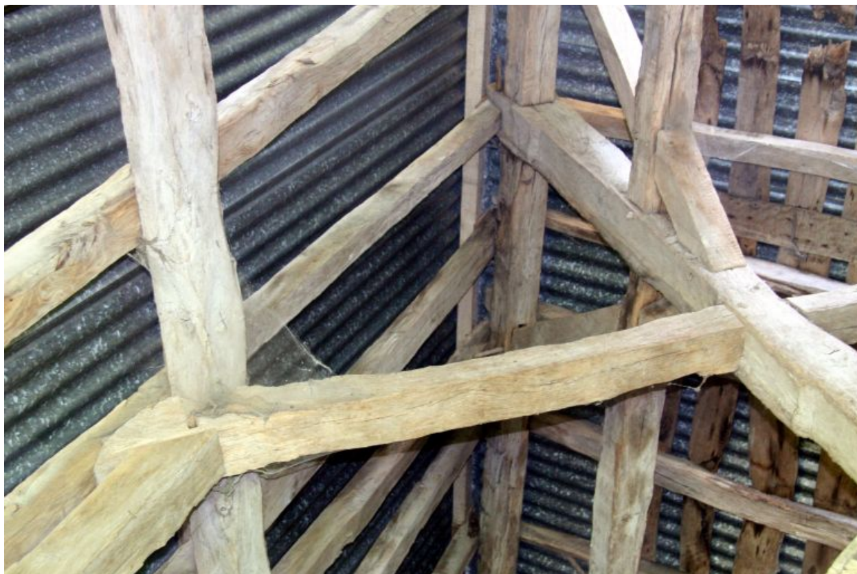
Aile ouest du logis : charpente à encoches avec sous-faîtage.
