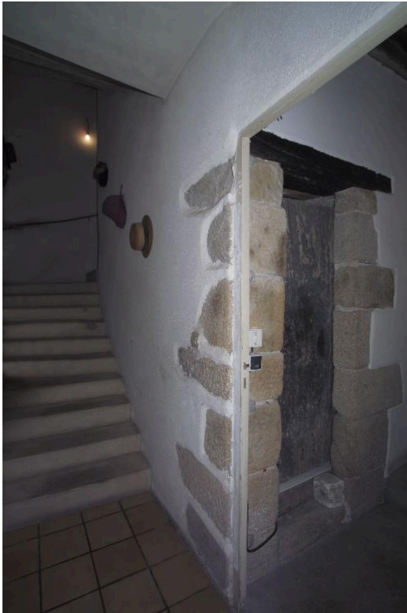
L'escalier, départ de la volée conduisant au deuxième étage.
