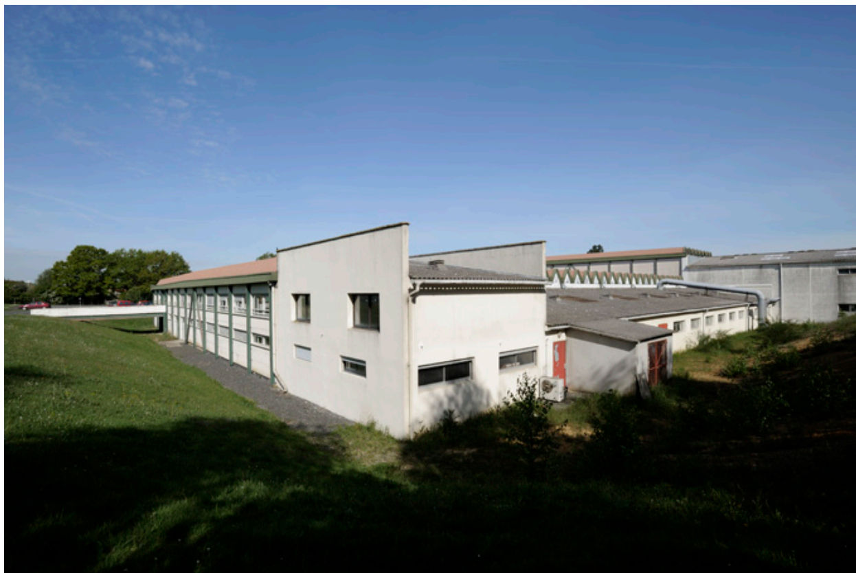
Usine SACAIR : façades sud et est.
