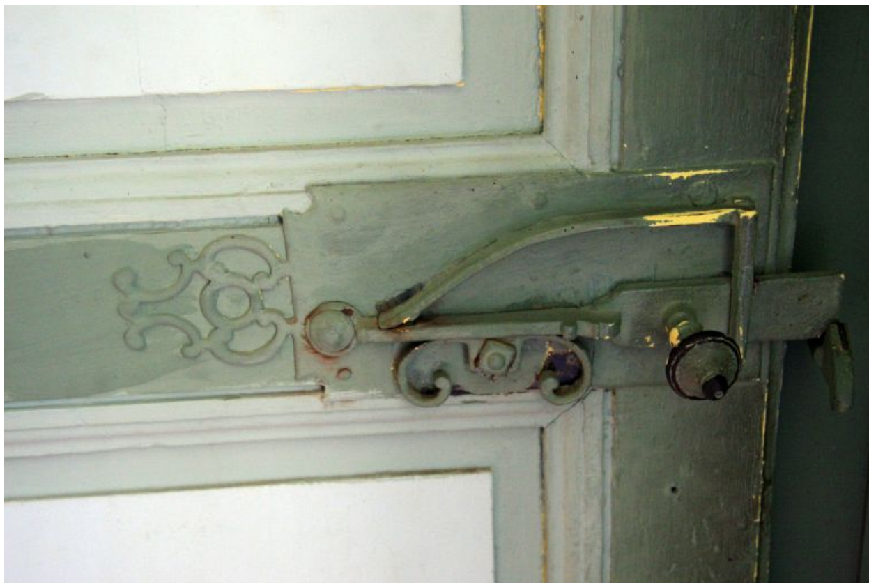
La salle à manger, porte intérieure : loquet.
