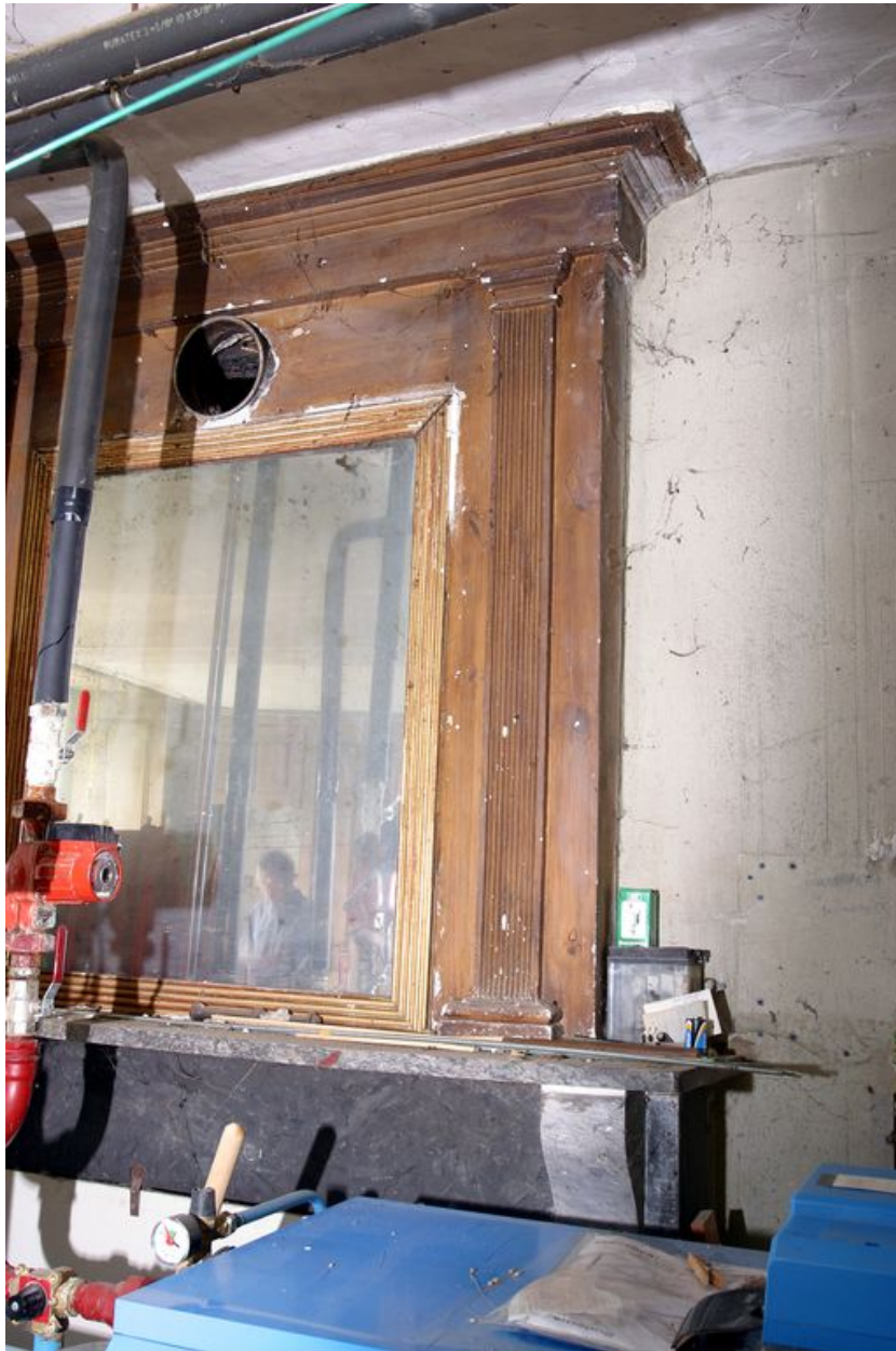
Rez-de-chaussée, salle nord : détail de la cheminée.
