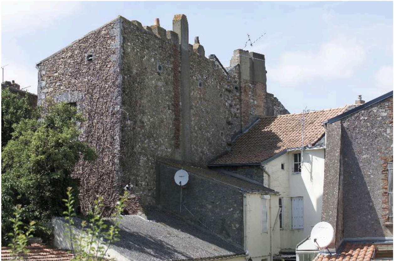
Maison, 11 rue du Général-De-Gaulle.
