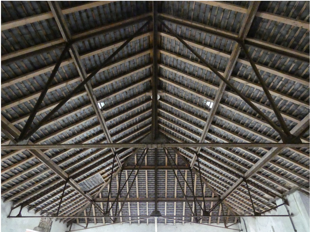
Le grenier à l'étage du corps principal de bâtiment sud, côté ouest : la charpente métallique.
