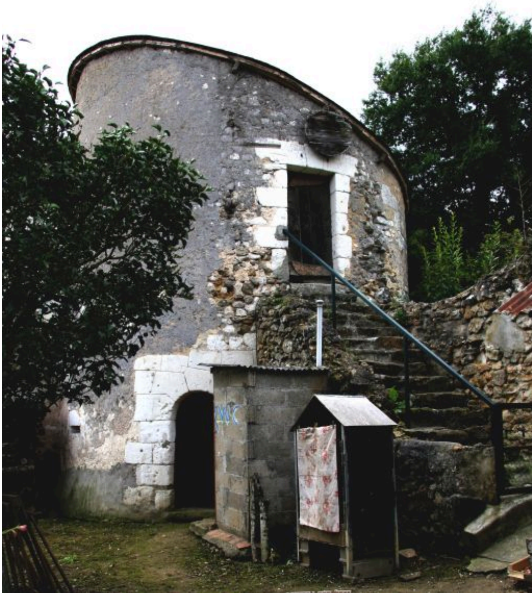
Tourelle, face interne : portes d'entrée du rez-de-chaussée et de l'étage.
