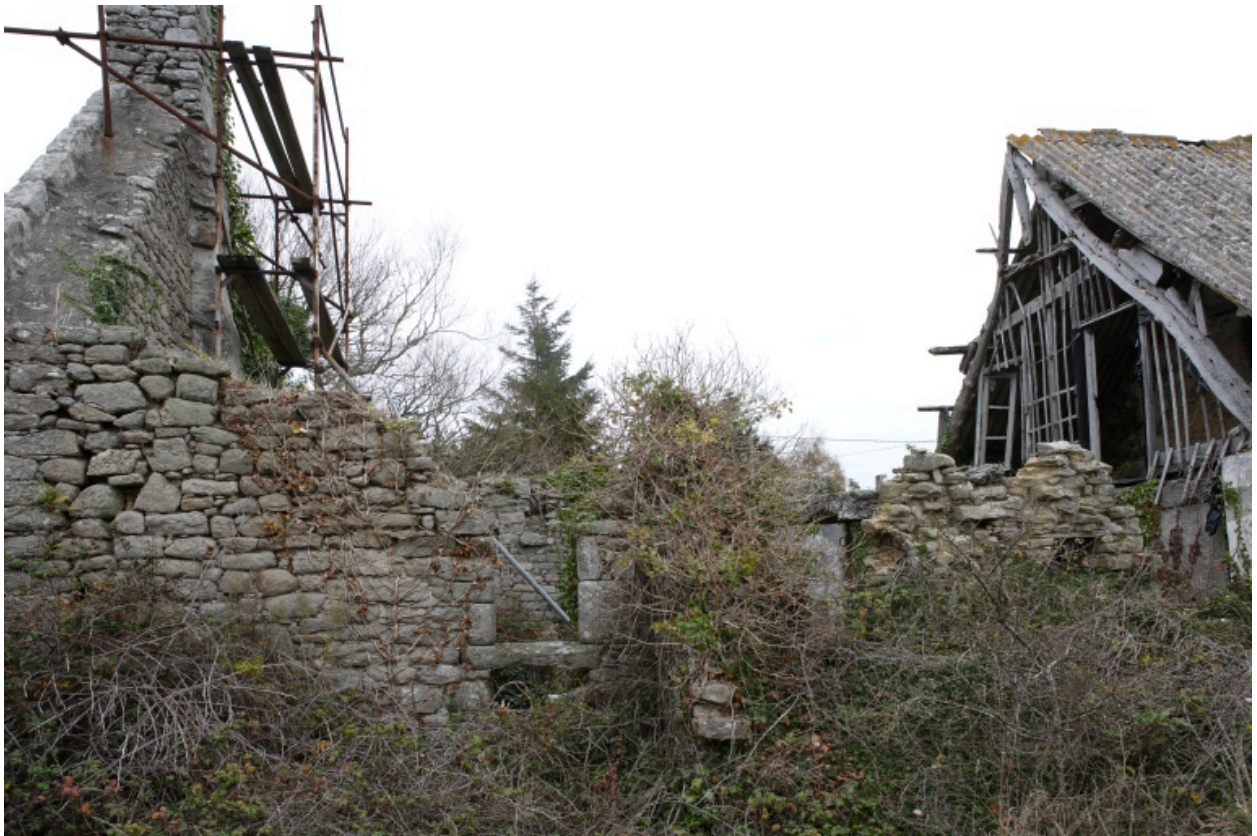
Vue du mur gouttereau sud.
