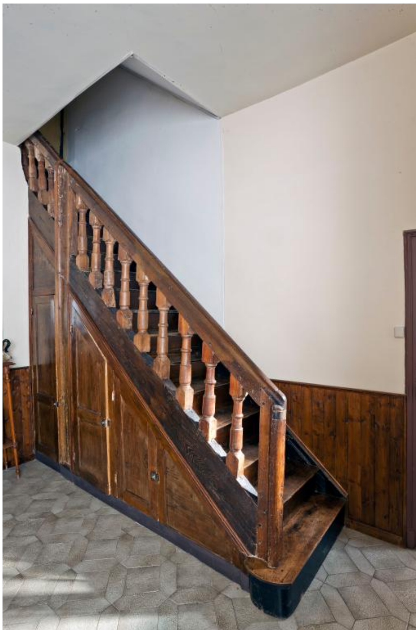
Maison, rez-de-chaussée, pièce à feu ouest : escalier menant au comble.
