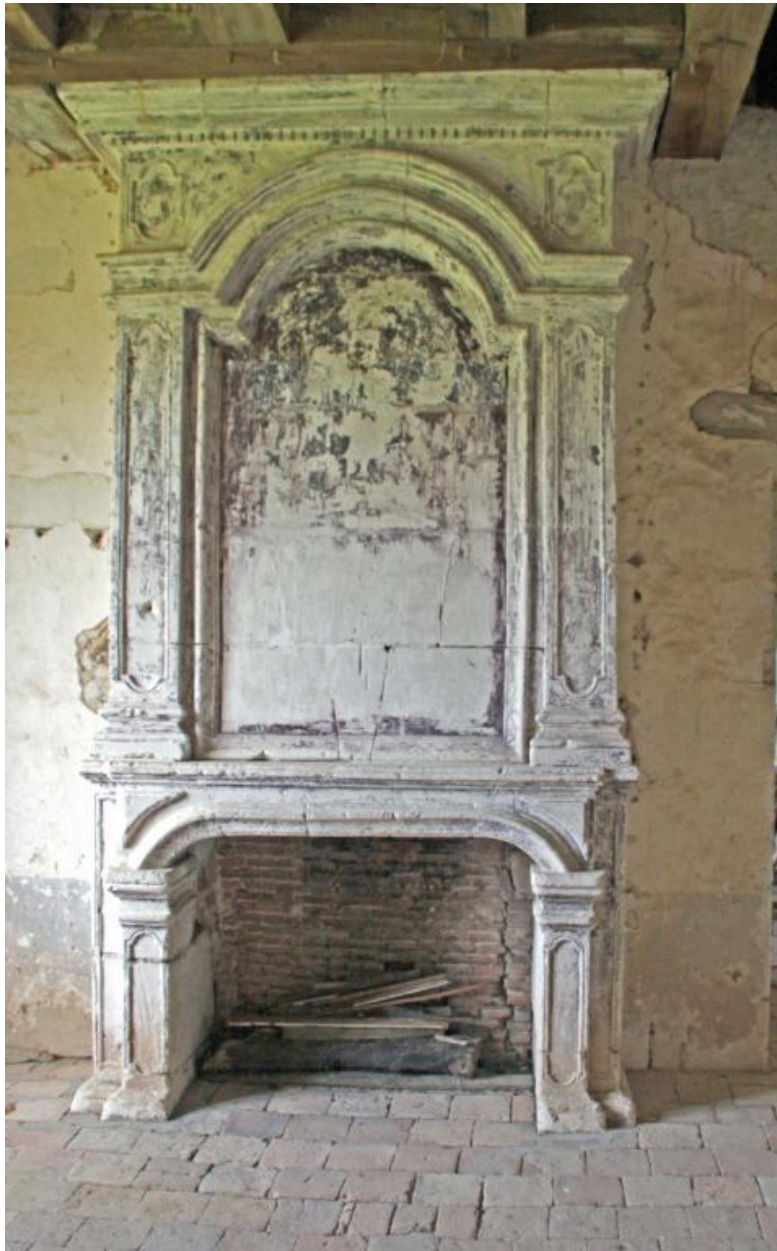
Pavillon, étage côté jardin, salle à feu : cheminée.
