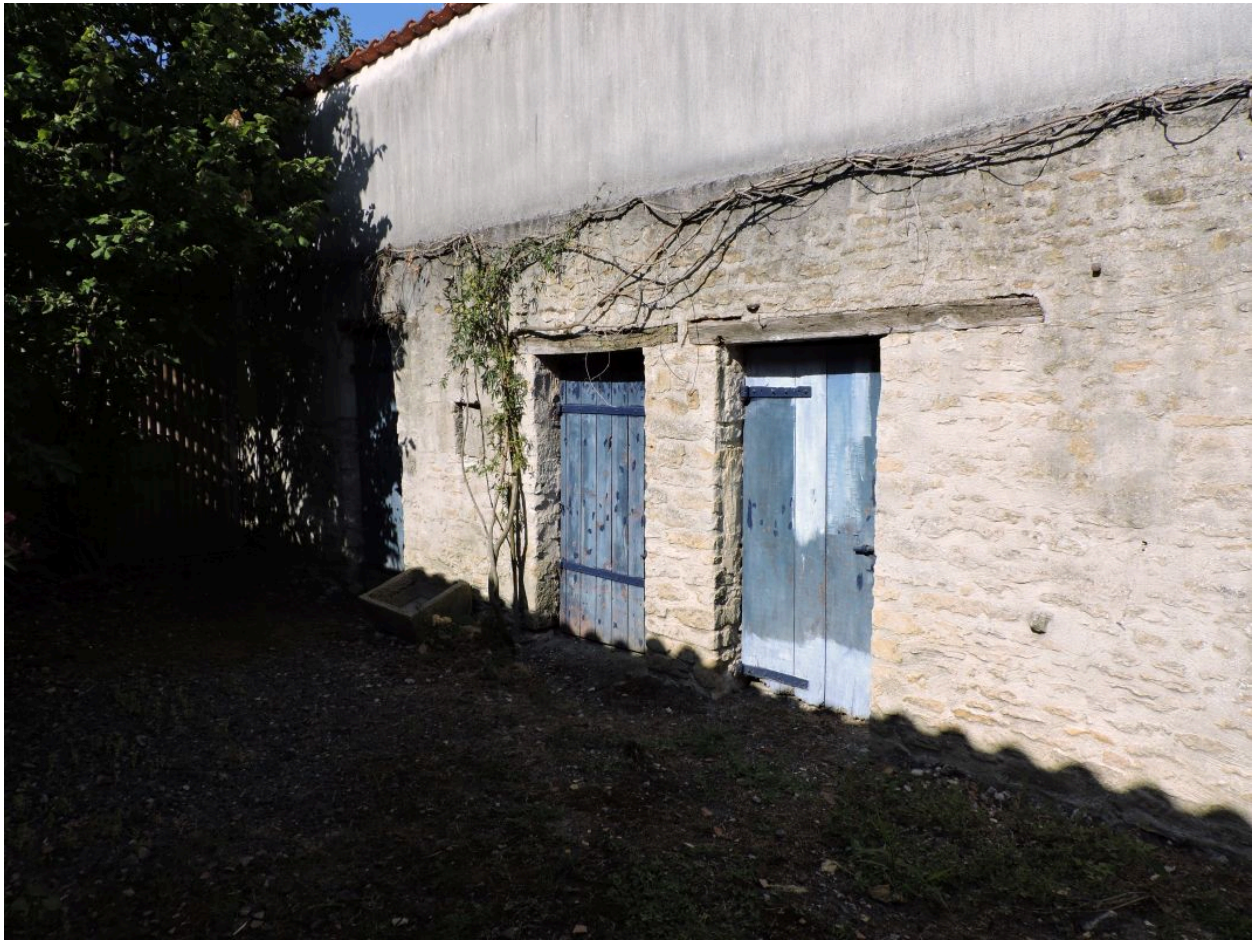
Ancien toit à porcs, au sud-ouest, de l'ensemble vu depuis le nord-est.
