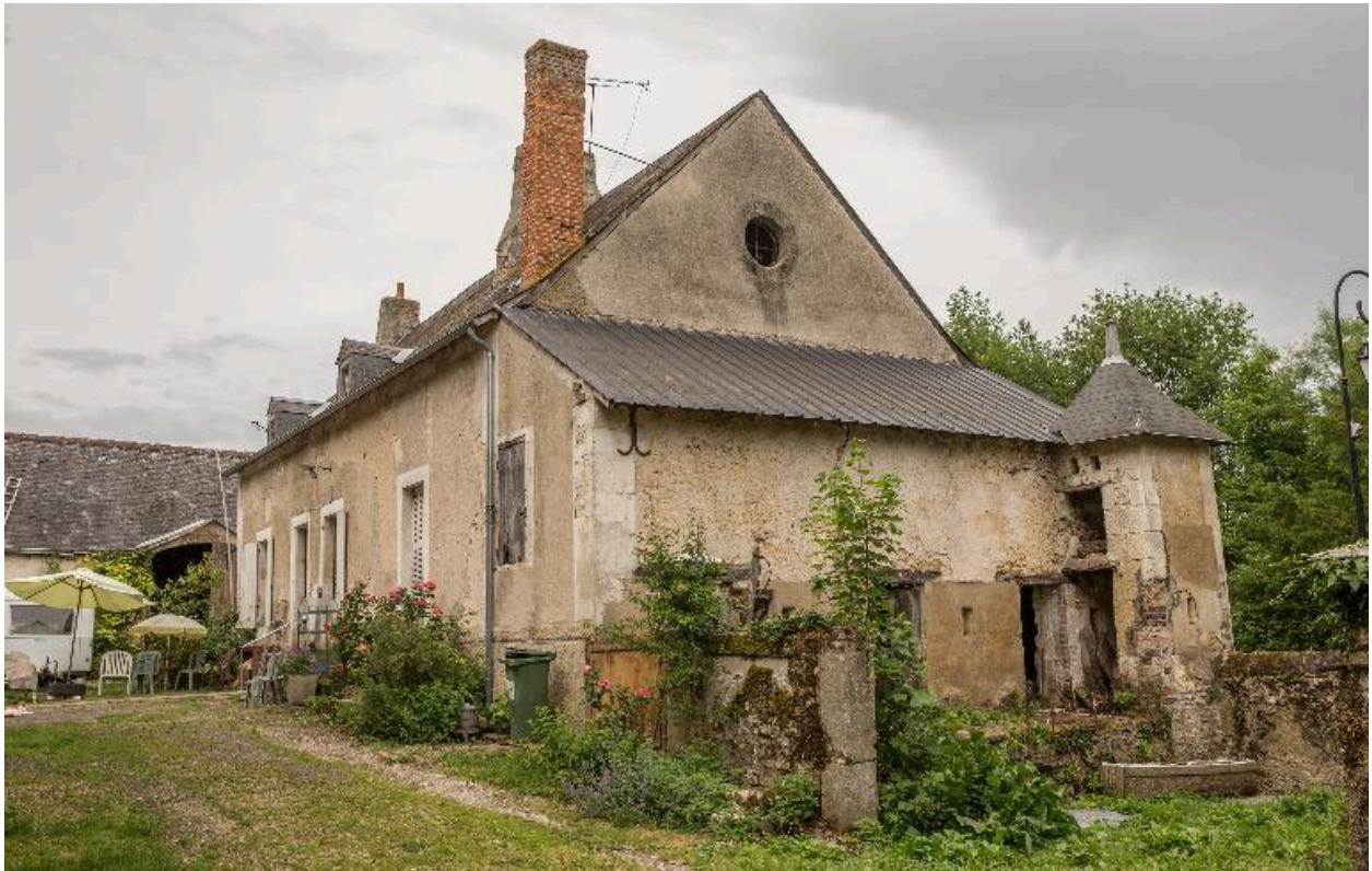
Le logis, façade sur cour, et les soues.
