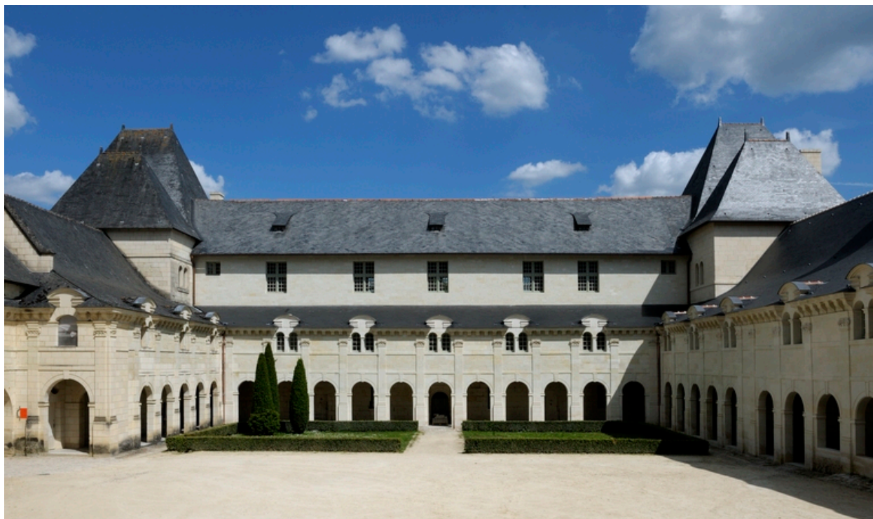
Cour Saint-Benoît, galerie des Infirmeries (érigée vers 1580).
