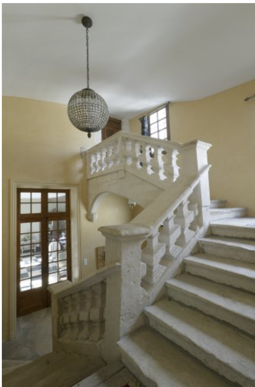
Vue d'ensemble de l'escalier.
