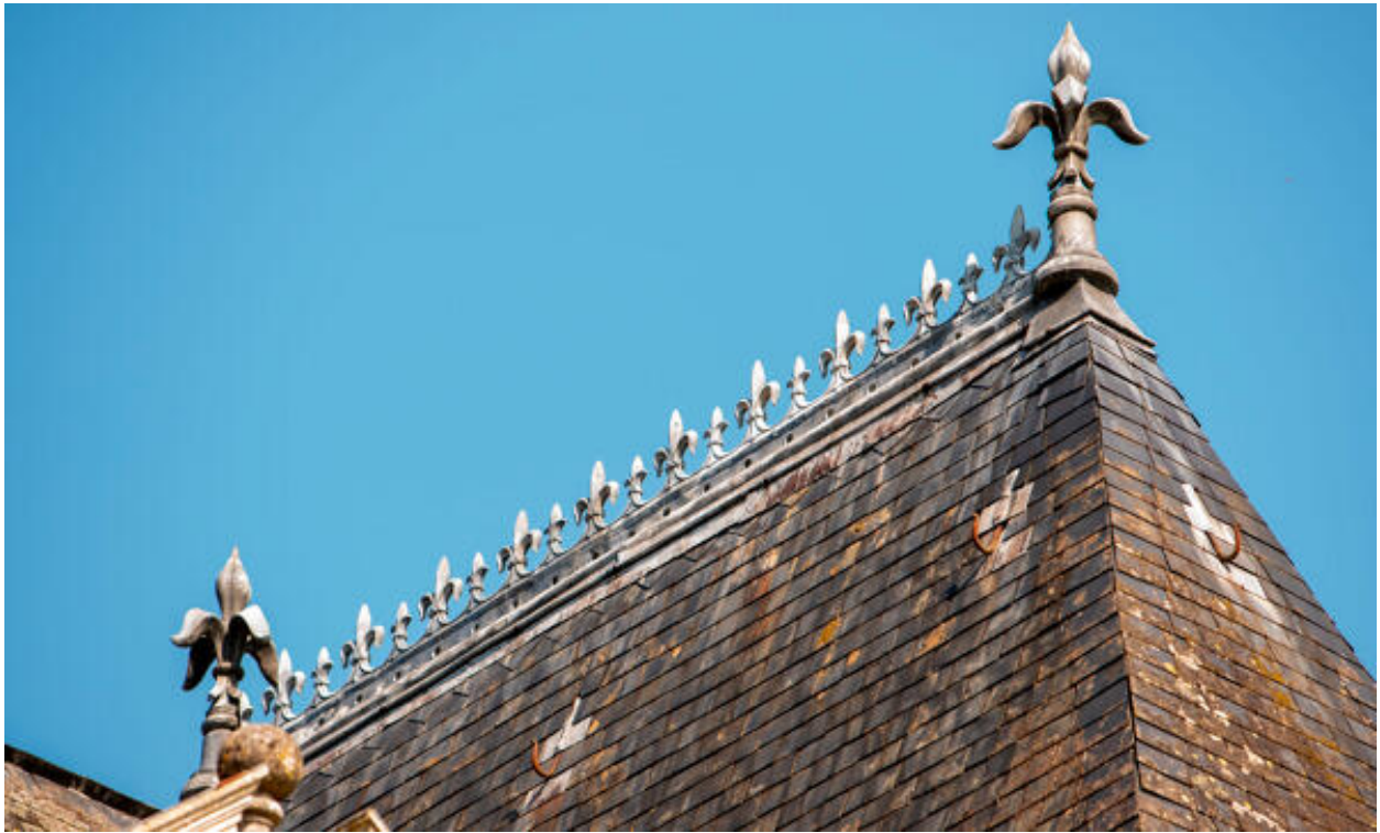
Le pavillon nord-est, crête et épis de faîtage.
