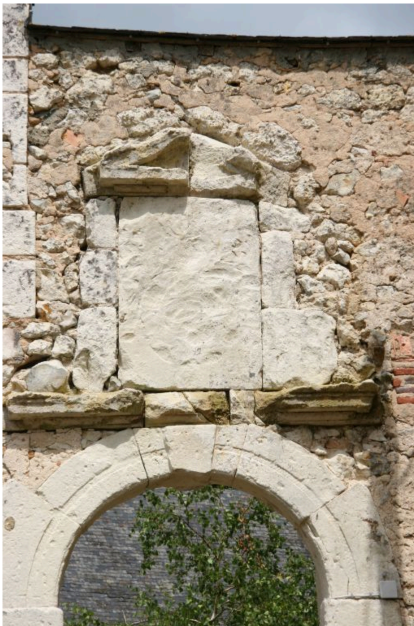
Porte piétonne du portail : arc en plein cintre et vestige d'un bas-relief.
