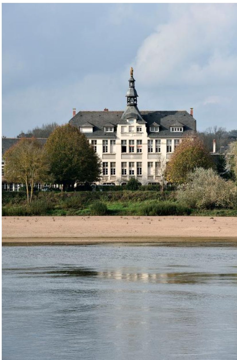
Vue de l'établissement diocésain, depuis le sud.
