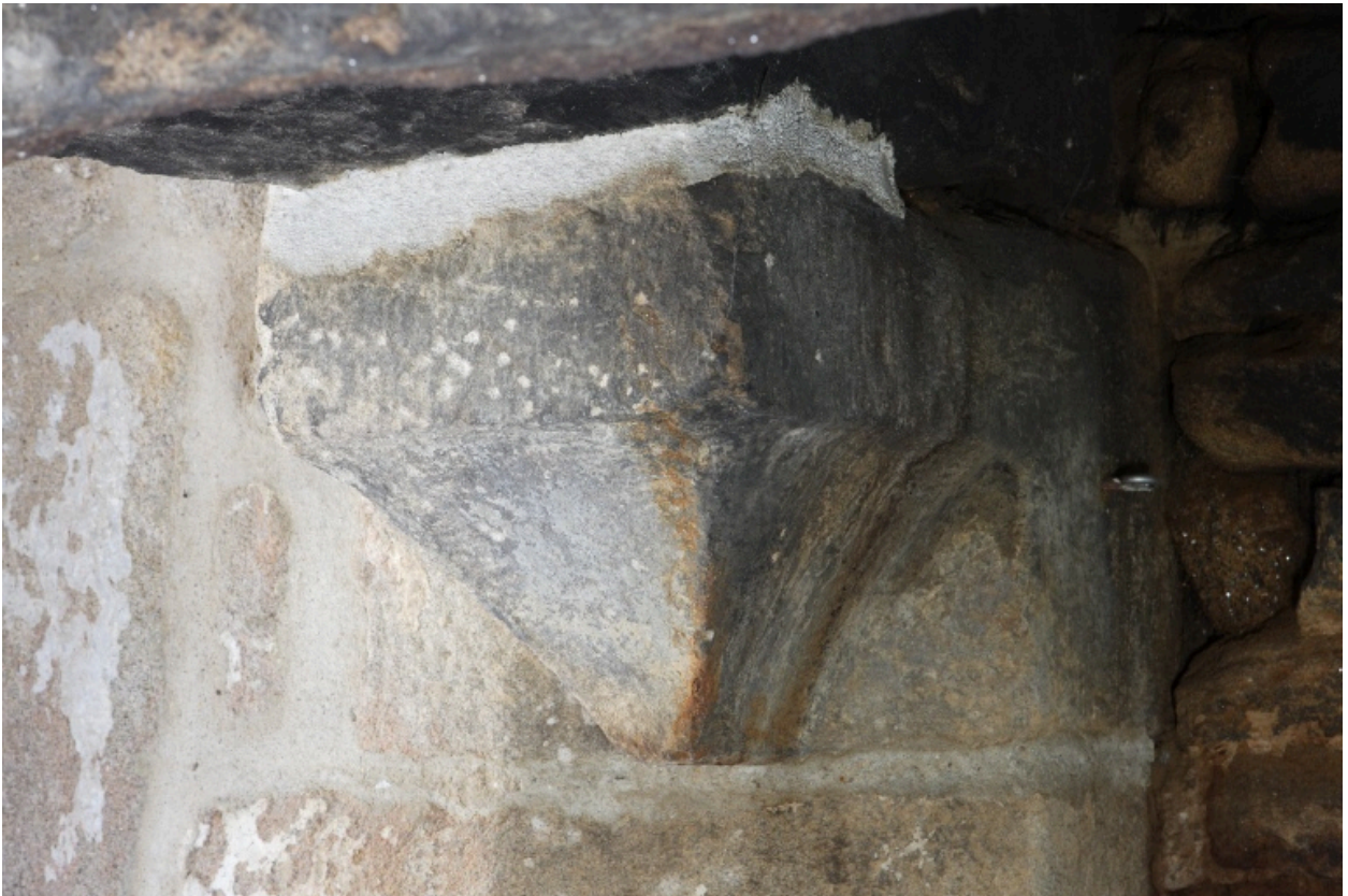
Détail d'une console de la cheminée (4 rue de l'Aha).
