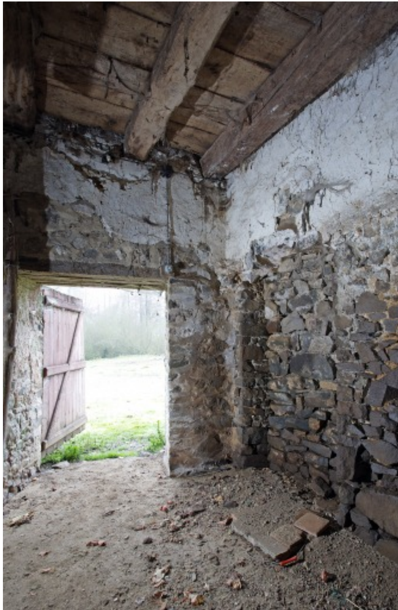
La chapelle, vue intérieure. Ancienne et actuelle portes de la partie ouest du rez-de-chaussée, vues depuis le nord.
