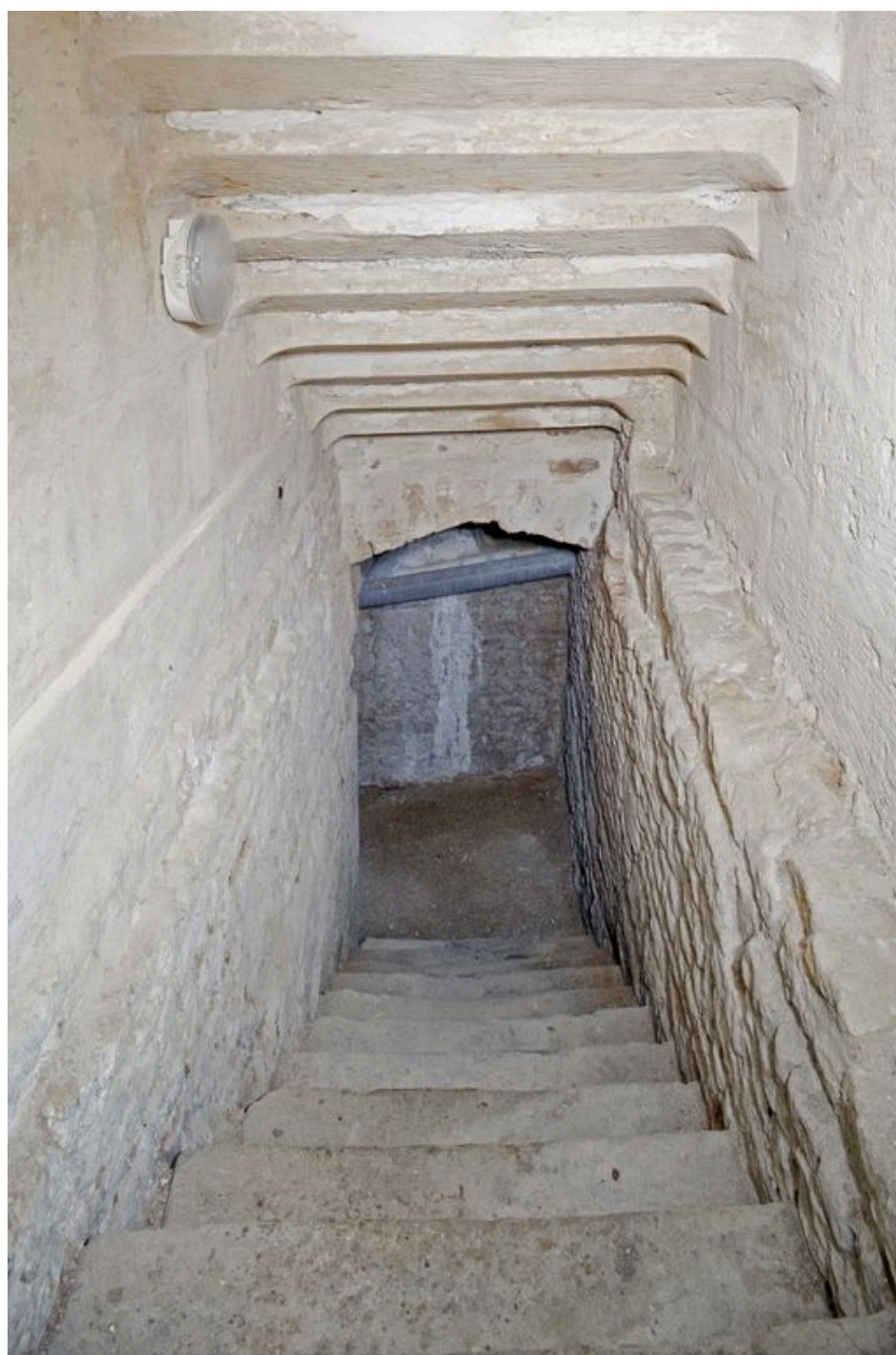
Escalier de descente au sous-sol.
