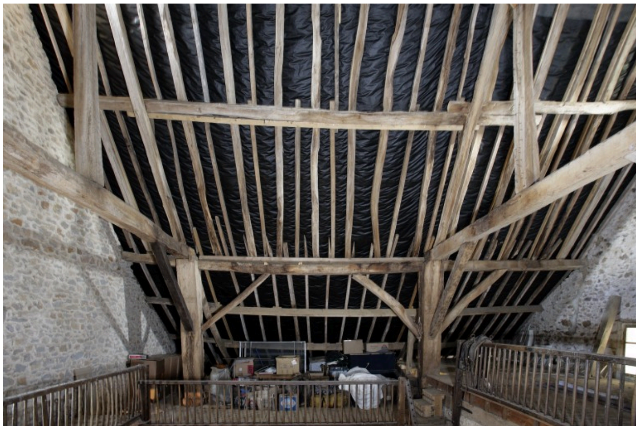
Grange-étable : vue intérieure vers l'est.
