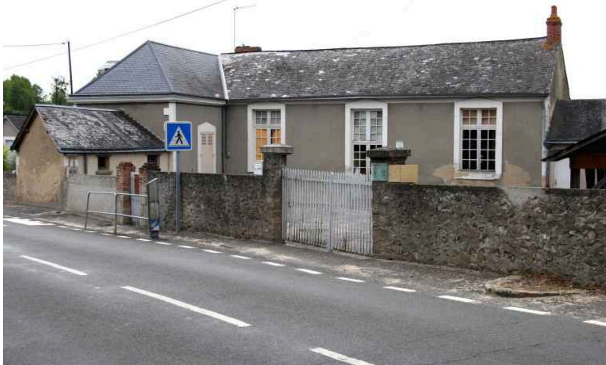
École de filles : vue d'ensemble prise de l'est.
