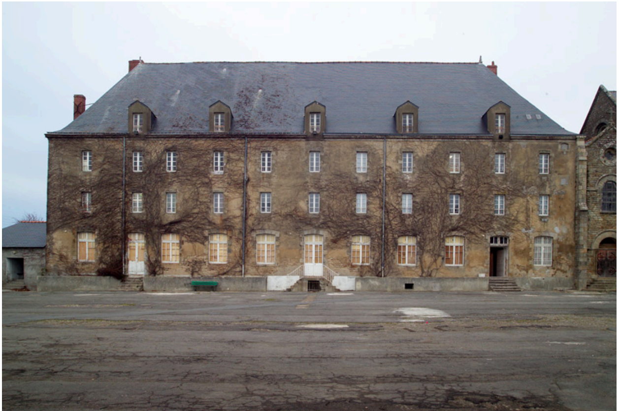
Façade arrière du bâtiment est.
