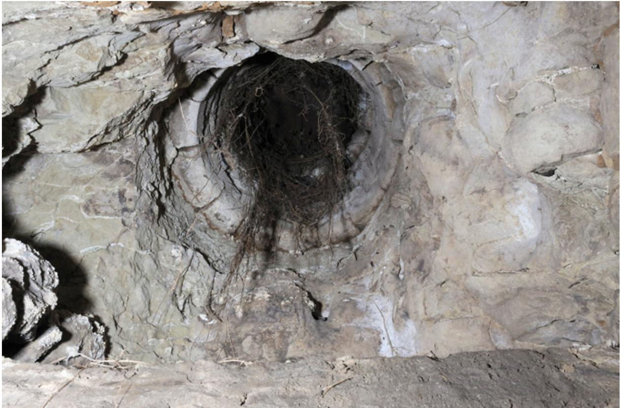
Cheminée, précédant le four : conduit (de section circulaire et en partie appareillé) d'évacuation des fumées jusqu'à la surface (aujourd'hui obturé).
