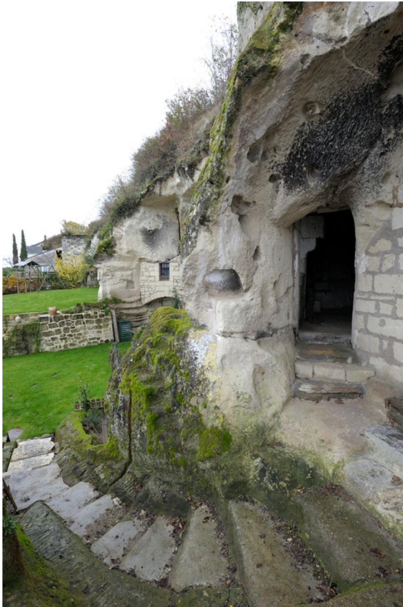
Escalier tournant extérieur d'accès à l'abri troglodytique, taillé dans le coteau.
