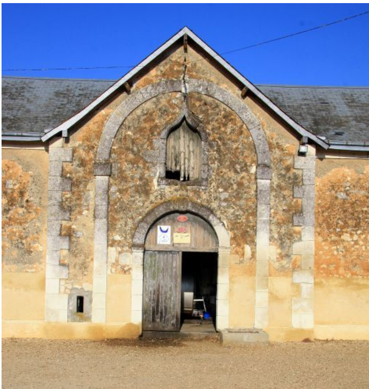
Les étables nord-est : détail de la travée centrale.
