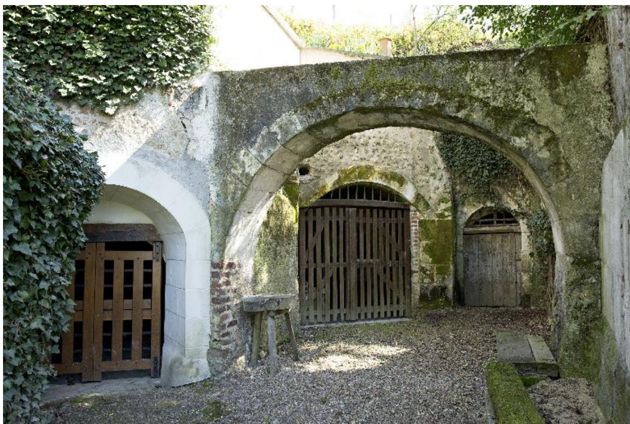
Cavier de Saint-Amadou, Ruillé-sur-Loir. Arche de consolidation (?).
