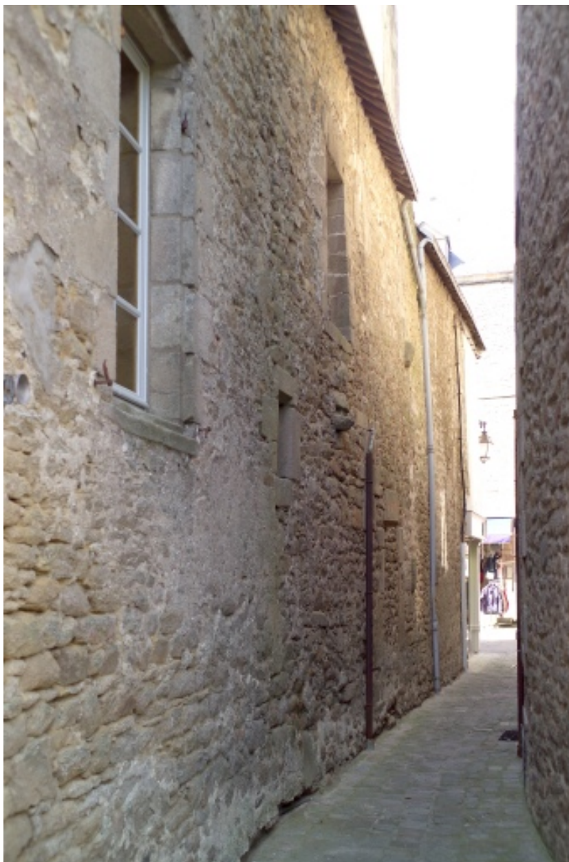
Vue du mur gouttereau dans la ruelle Saint-Michel.
