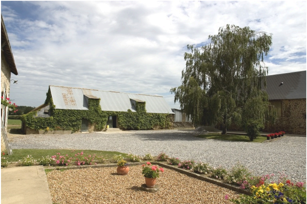
L'ancien logis-étable et l'étable-grange vus depuis la cour au sud.
