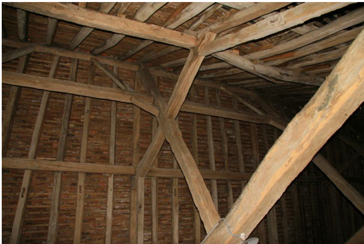
La grange, charpente avec sous-faîtage.
